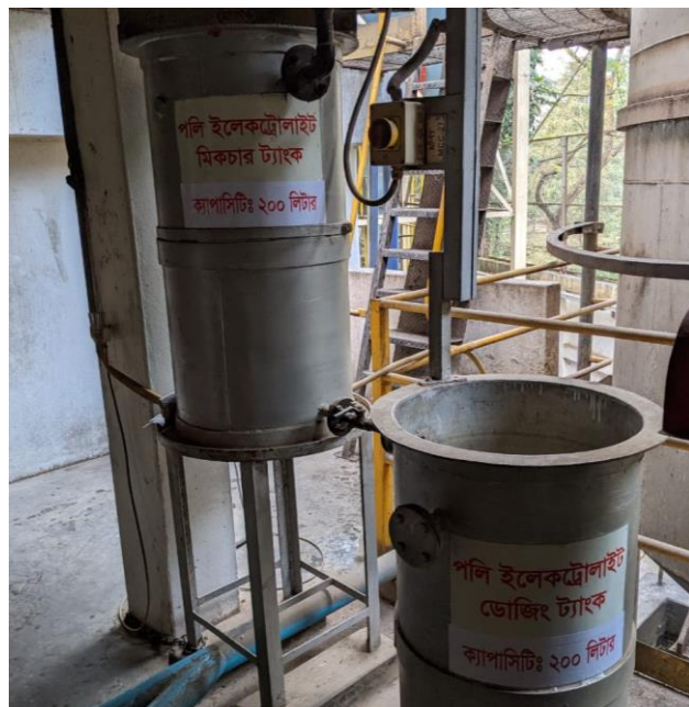
Chemical Dosing Tank (ETP)
