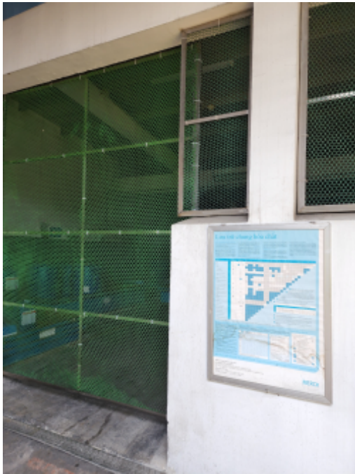
Chemical Store 1b.jpg
