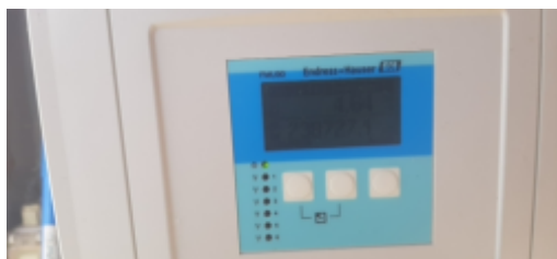
Flow meter, discharge point.jpg
