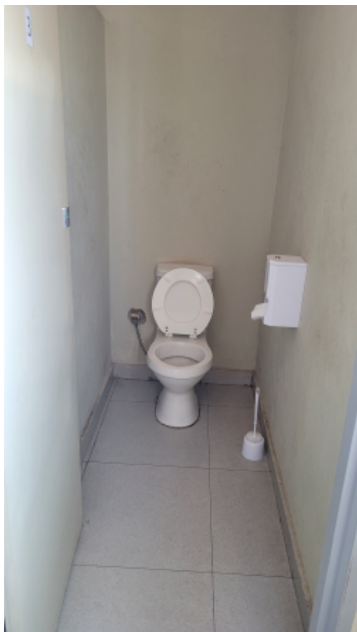
Site Change Room toilet.jpg
