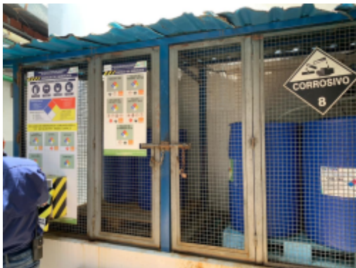
Almacen de productos corrosivos.jpg
