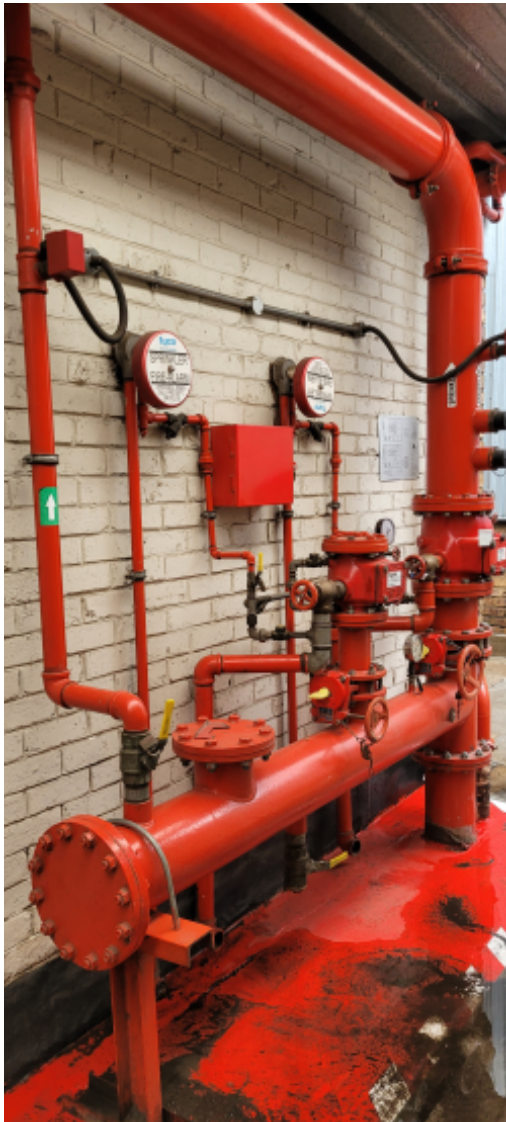
Fire suppression sprinkler system.jpg
