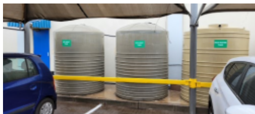
Site rainwater and effluent tanks photo 2.jpg
