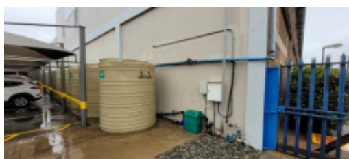
Site rainwater and effluent tanks.jpg
