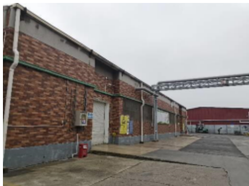
Hazardous waste warehouse-Tuanjie Plant.jpg
