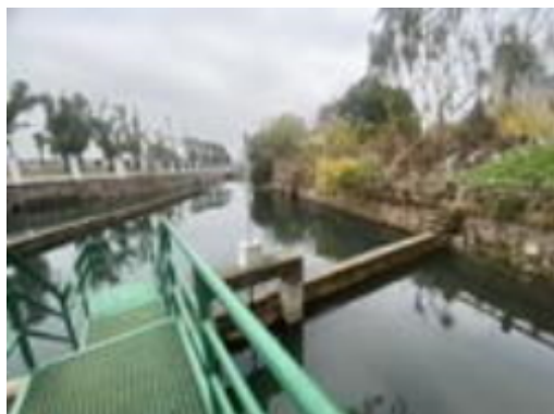
Oxidation pond-Tuanjie Plant.JPG
