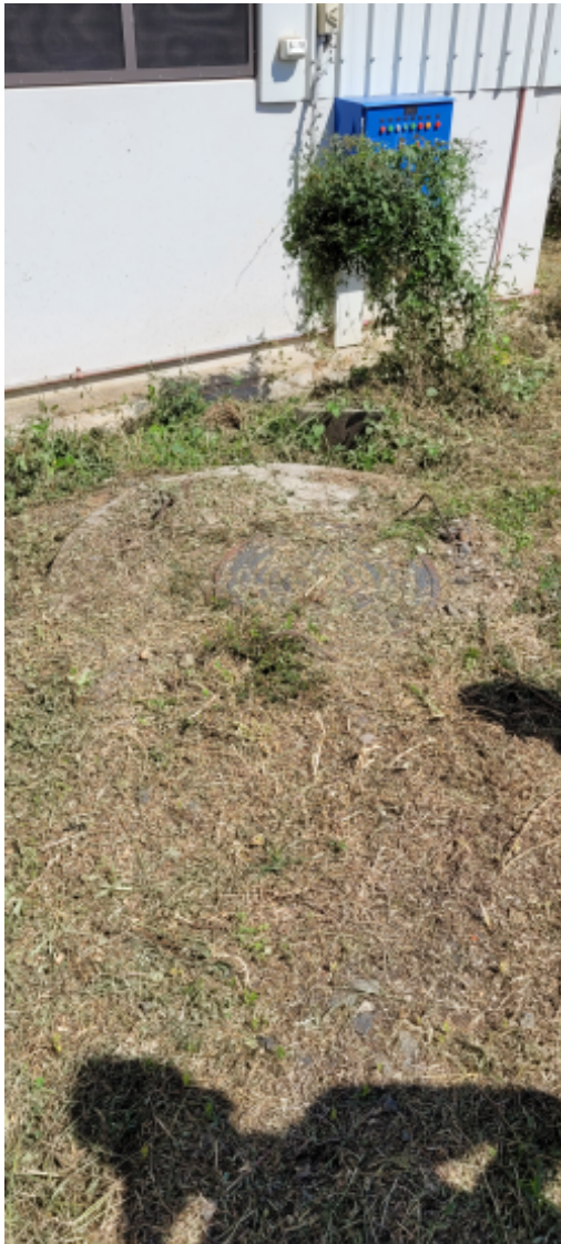
Effluent Pit drain.jpg
