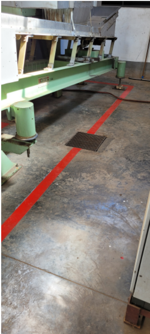
Drain in GLT Plant.jpg
