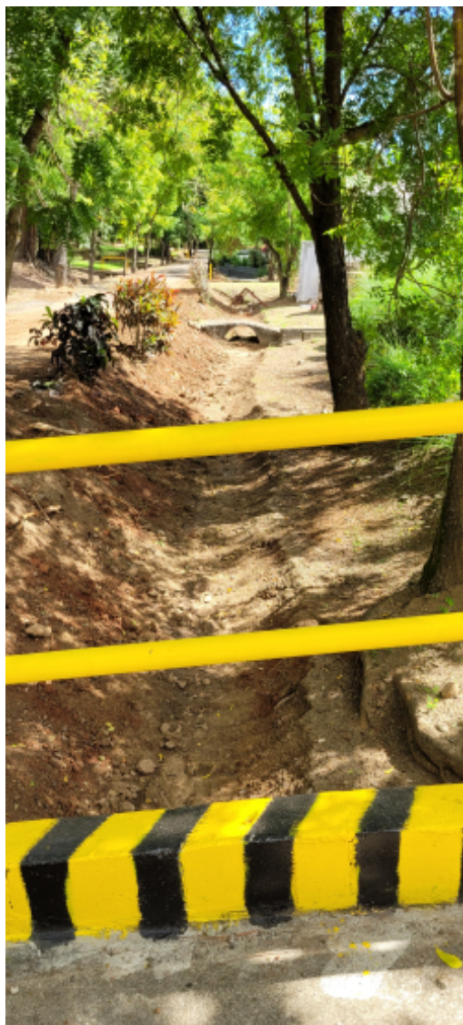
Stormwater drain 2.jpg
