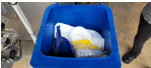
Spill kit at new boiler.jpg
