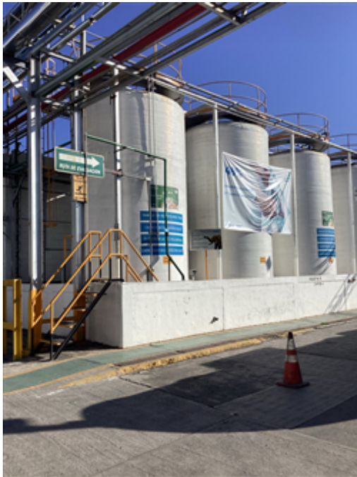
tanques de almacenamiento agua pluvial.jpg
