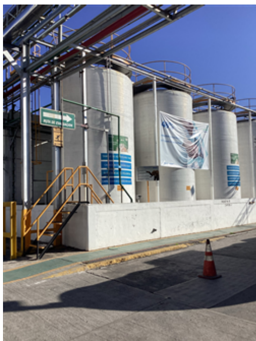
tanques de almacenamiento agua pluvial.jpg
