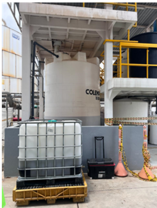
Contención sustancias PTAP 4.jpeg
