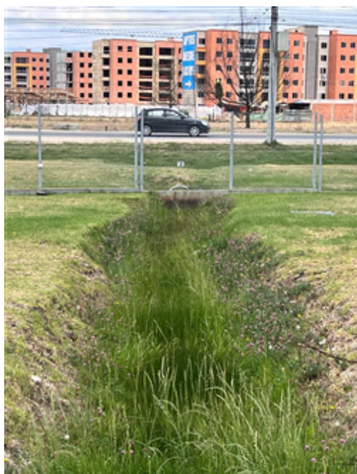
Vallados de aguas lluvias.jpeg
