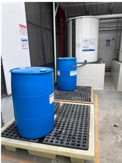
Contención sustancias PTAP 2.jpeg
