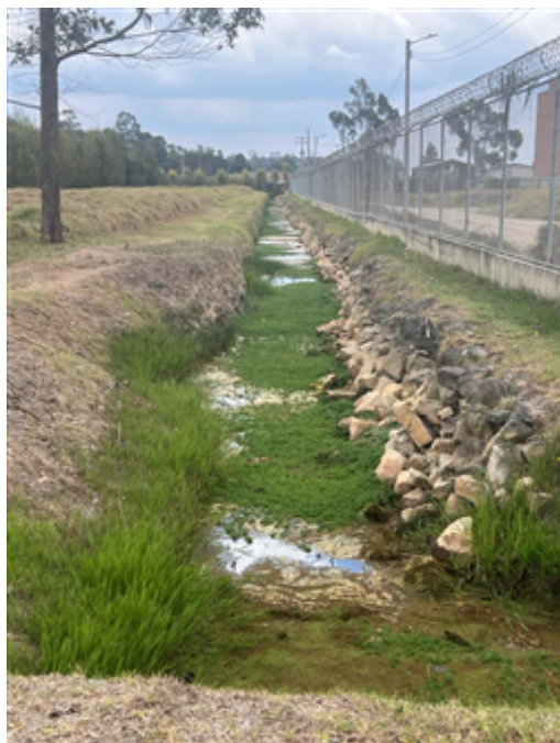
Vallados de aguas lluvias 2.jpeg
