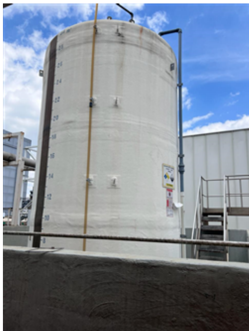
Contención sustancias PTAP 5.jpeg
