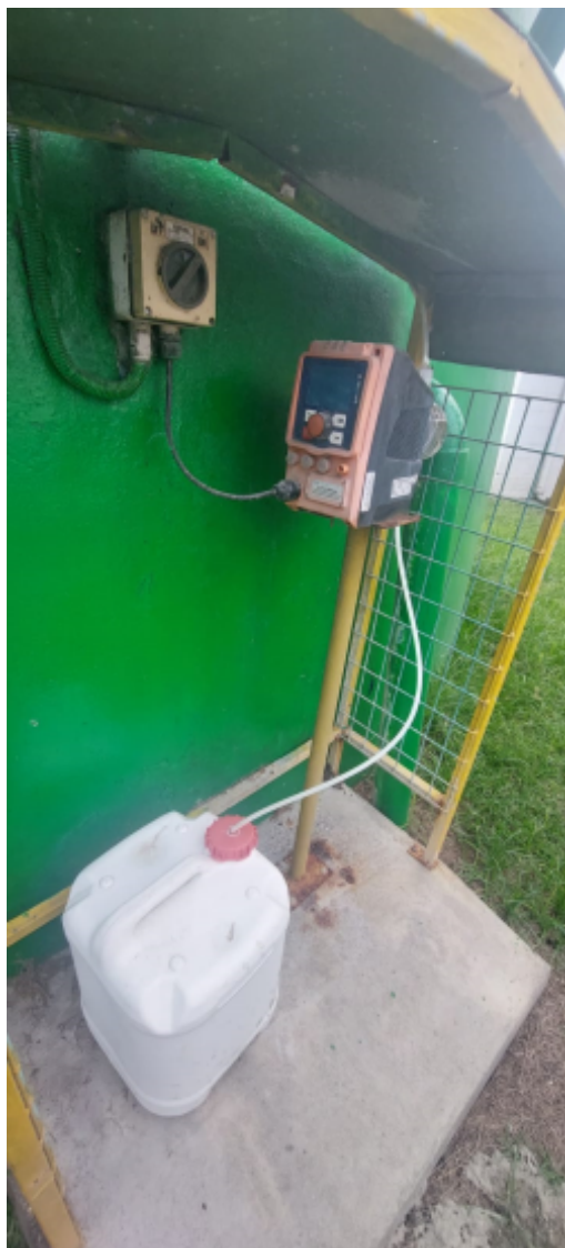
Chlorine dosing pump.jpg
