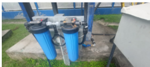
Rainwater filters.jpg
