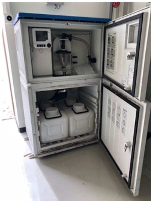
sampling device - effluents.jpeg
