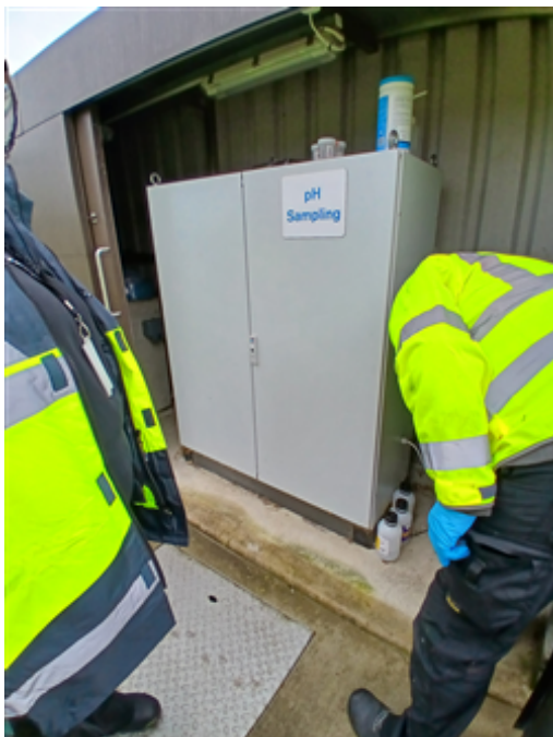
21 OC Effluent pH sample point.jpg
