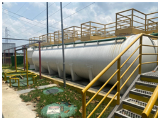
4.DETP - biodigestor.jpeg
