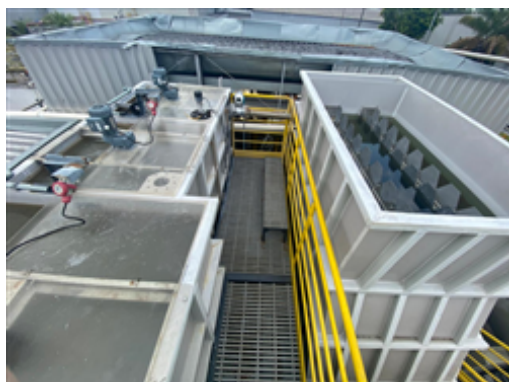
6. IWTP - Lamellar decanter.jpeg
