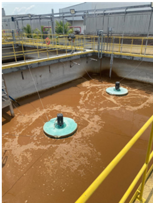
6. IWTP - CT05 - Homogenization tank1.jpeg
