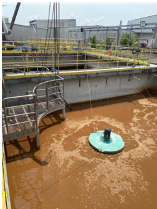
6. IWTP - CT05 - Homogenization tank.jpeg
