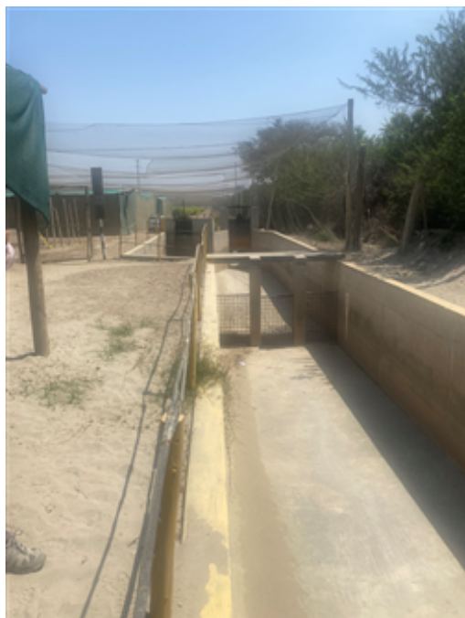
Entrada-Bocatoma de agua superficial fundo Don César IMG_3436 (1).jpg
