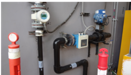
effluent flow meter.JPG
